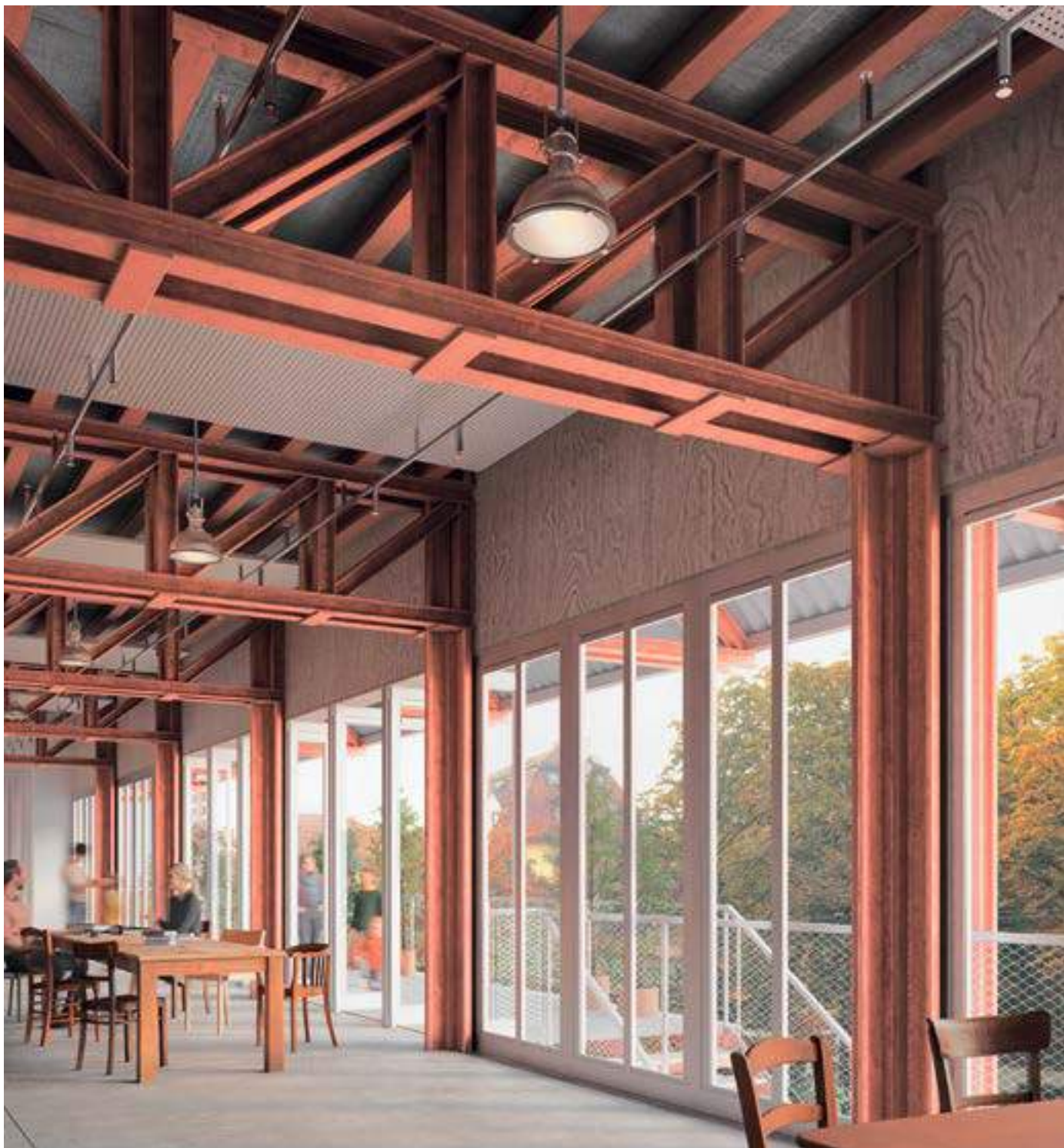
Zwillingsfachwerke in Querrichtung prägen das Stadtgeschoss und bilden eine auskragende Überdachung der Anlieferung.
