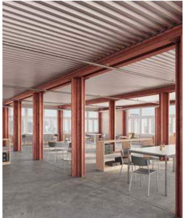
Schienen dienen als Unterzüge und Träger, zudem werden sie als tragende Stützen zusammengeschweisst
