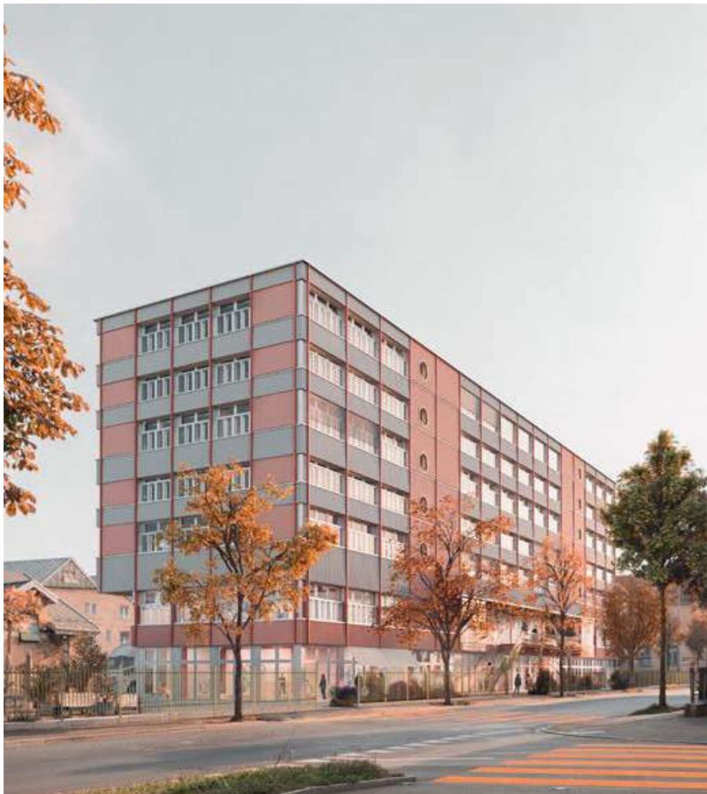
Die Gebäudehülle mit ReUse-Kastenfenstern und -Welleternitplatten von der Hohlstrasse gesehen.
